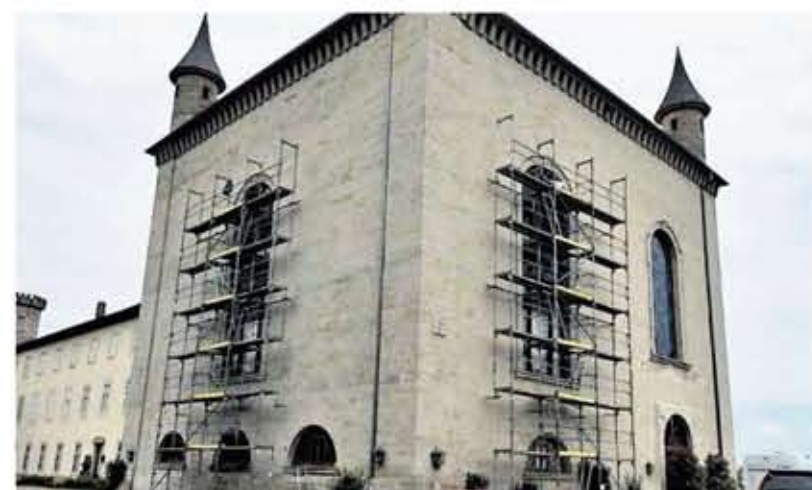
Am Schloss Derneburg werden die Fenster des Rittersaals restauriert.
