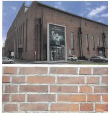
Hannover Hannomag Werke, Göttingerstrasse, MuKa Fugenmörtel, ohne Scherben farblich angepasst
