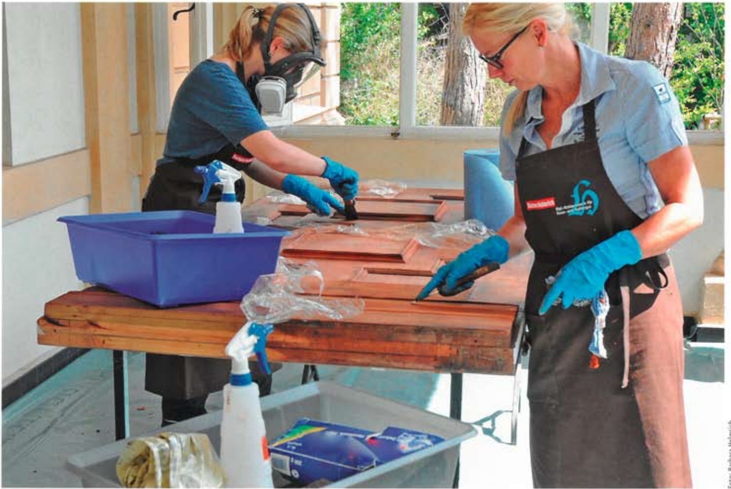
Lackabnahme an einer großen Kassettentür.
